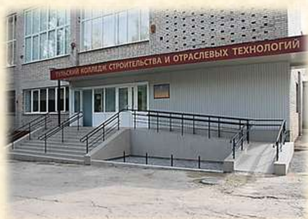
Вид после ремонта
