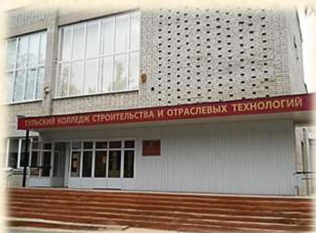
Вид до ремонта
